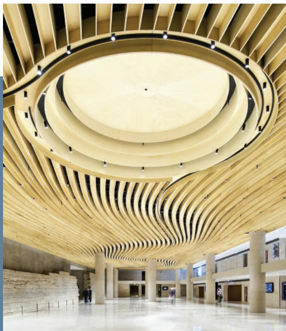
**Carrousel du Louvre** | Plafond ignifugé par application du système intumescent Verniflam®
